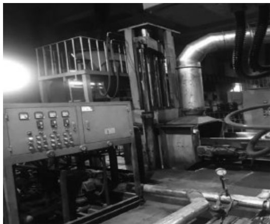
图1 拆机现场照片
